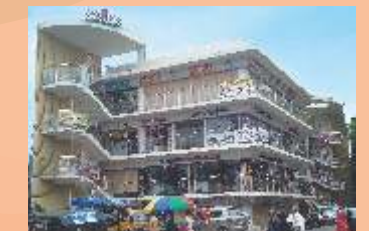
Saaff Arcade, Koilandy. Actual Project
