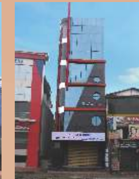
Painuthura Towers, Cochin. Actual Project
